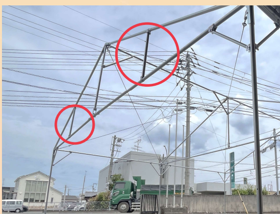
妻面の垂直部材を増設 大型テントでありながら、安定感を確保
