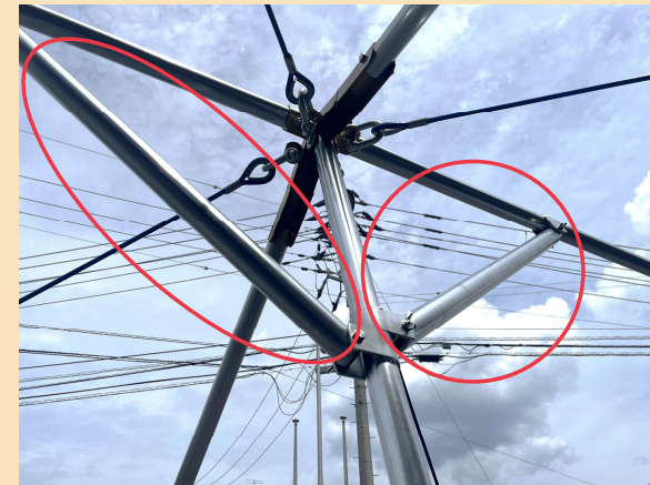
天井部各所へ補助パイプを増設 揺れを分散し安定感を確保します
